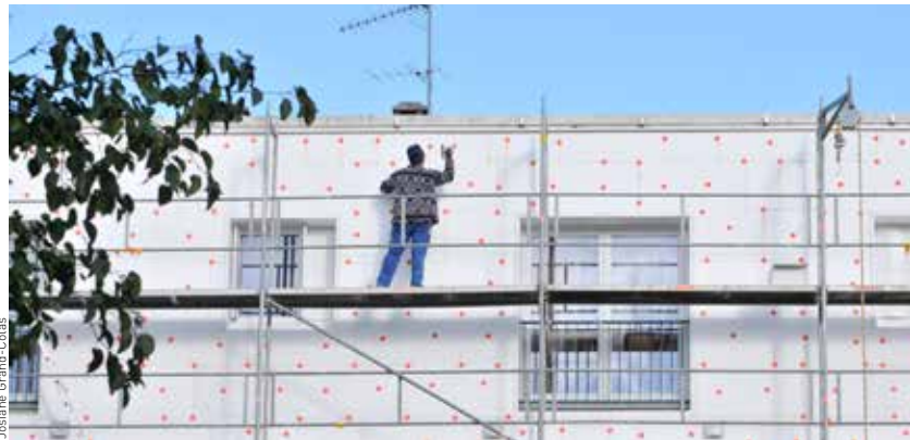
L'isolation des façades sur les immeubles contribue à réduire la consommation de chauffage.
