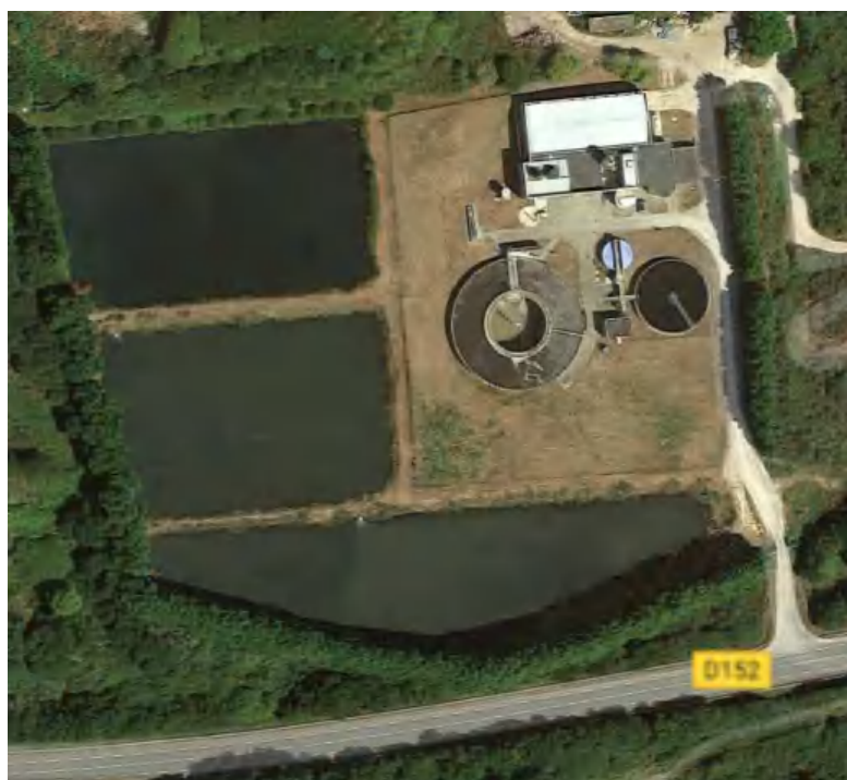
Figure 19 : station d'épuration de Kervennois - Ploemeur - Source : Géoportail -
