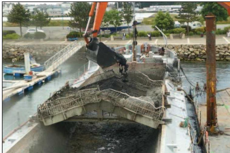
*Photo 6 : Chaland équipé d'un crible mobile à Loctudy [In Vivo]*
