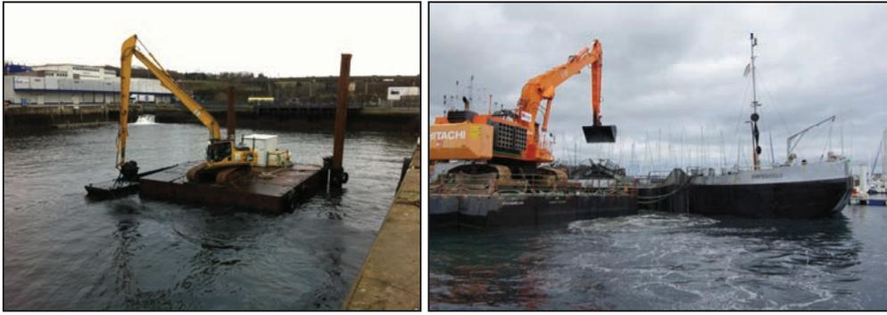
*Photo 1 : Exemples d'ateliers de dragage par pelle mécanique sur ponton avec chargement d'un chaland (à gauche : dragage de Concarneau en 2012, à droite : dragage de Loctudy en 2013) [In Vivo]*
