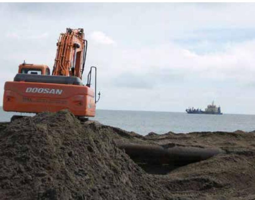
*Au printemps 2012, les sédiments dragués dans la passe ouest, qui permet aux plus gros bateaux d'accéder au port de commerce, ont permis le rechargement en sable de la grande plage de Gâvres.*
