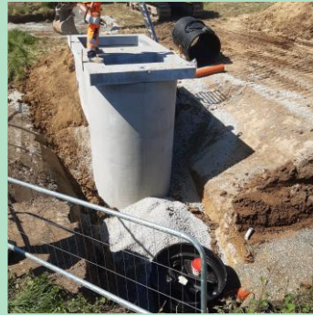
Travaux sur le poste de relevage Kerandré Hennebont
