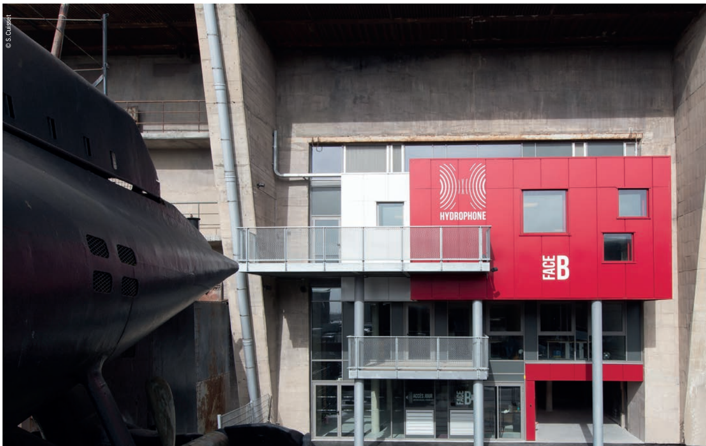
ENTRÉE CÔTÉ STUDIOS DE RÉPÉTITION ET BUREAUX
