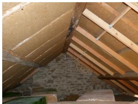
Isolation d'une toiture en fibre de bois
