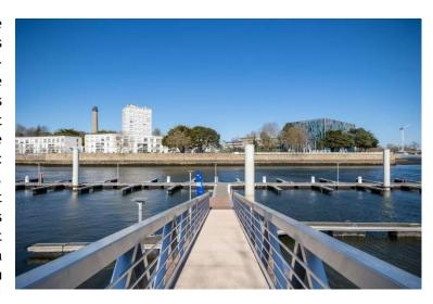
La panne B de l'avant-port de Lorient a également été modernisée afin de renforcer la résistance de l'infrastructure aux intempéries, en remplaçant les corps-morts existant par des pieux. De plus, dans l'objectif de faciliter et de sécuriser les déplacements, les catways (petits pontons flottants installés perpendiculairement au ponton principal) de la zone dédiée aux pilotes et aux lamaneurs ont été remplacés par un nouveau ponton adapté aux usages des unités de travail.
