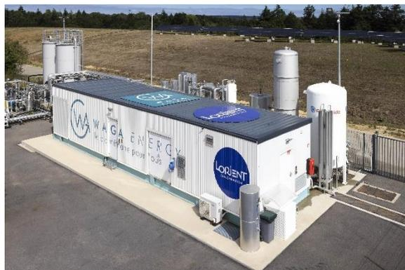
Depuis novembre 2019, le gaz émis par les déchets ménagers ultimes enfouis à l'installation de stockage des déchets non dangereux (ISDND) de Kermat à Inzinzac-Lochrist est transformé en énergie renouvelable et injecté dans le réseau de gaz naturel de GRDF grâce à l'installation d'une Wagabox.
