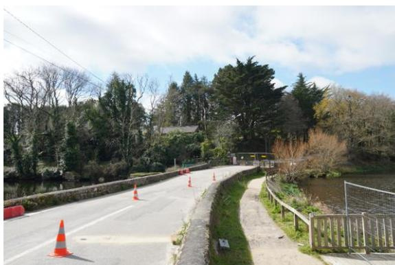
Dans le cadre des travaux de consolidation, du béton va être injecté dans des points de forage creusés jusqu'à 6 mètres de profondeur sur la totalité de la digue de façon à combler les cavités repérées dans l'ouvrage. La méthode utilisée permettra de limiter l'impact éventuel du chantier sur le milieu. Les travaux se dérouleront du lundi au vendredi de 7h à 19h et pourront occasionner des désagréments sonores liés principalement aux forages pour les riverains et les promeneurs.
